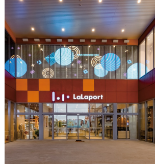
南館エントランス
